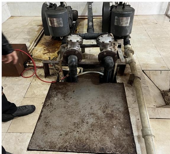
地埋式污水处理系统（接市政管网提升泵）
