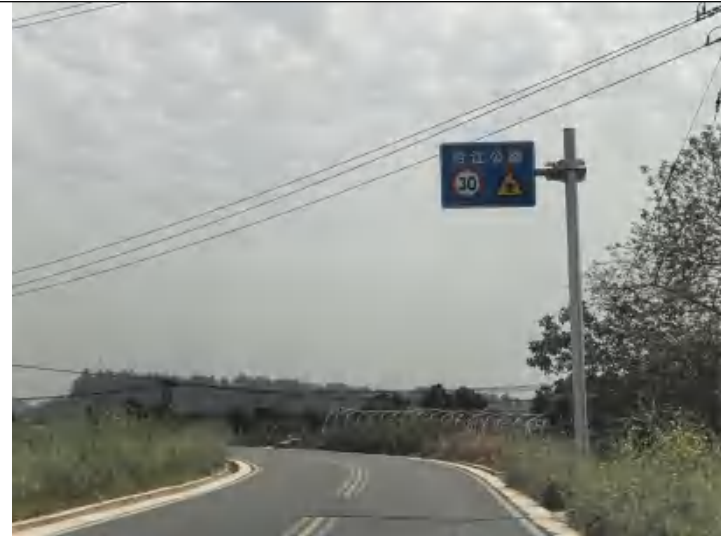
路面、排水沟、护坡
