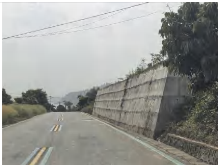
排水沟、护坡整治
