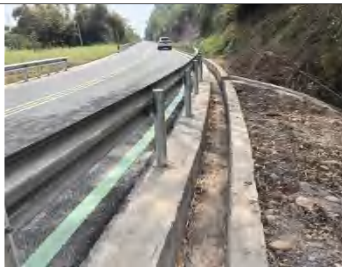
路面、排水沟、护栏
