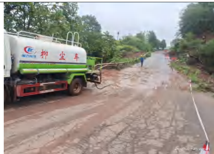
路面、排水沟、护坡
