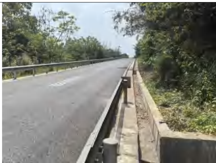
路面、排水沟、护栏
