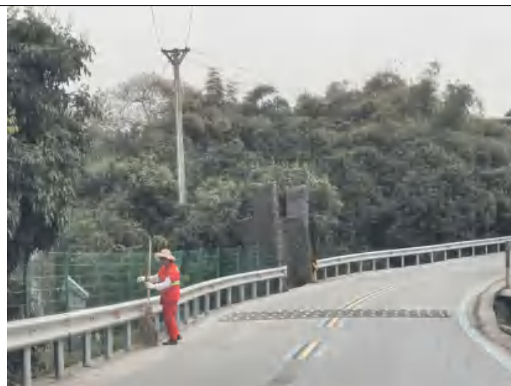
K0+080 位置道路及边坡、雨水收集沟（右）
