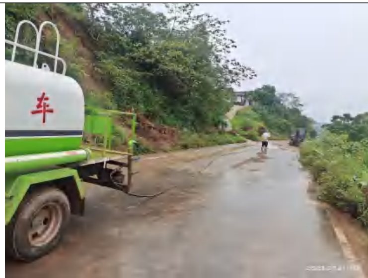
K0+080 位置道路及边坡、雨水收集沟（右）
