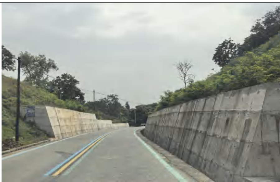
路面、排水沟、护坡
