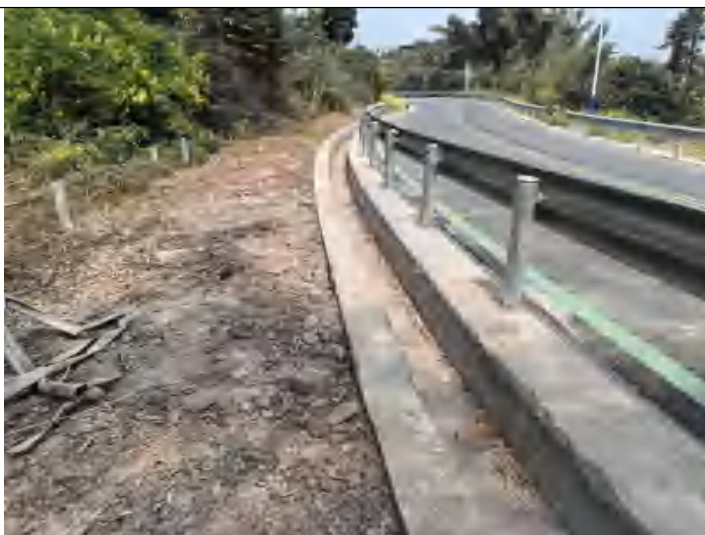
路面、排水沟、护栏
